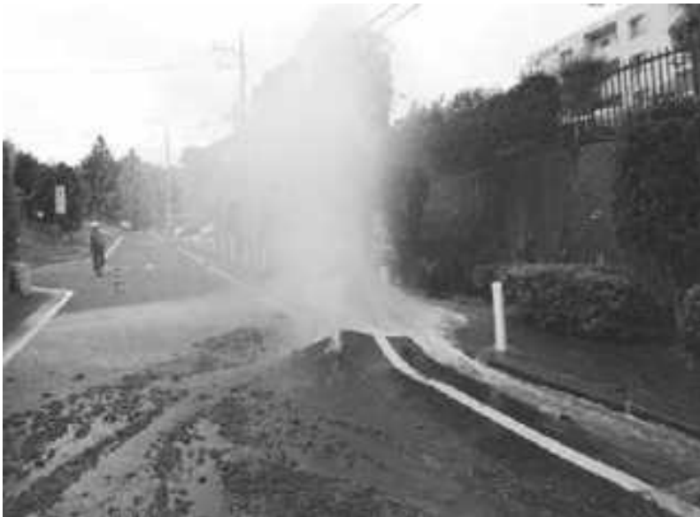
水道管の突発破裂事故 出典: 水道技術研究センター
