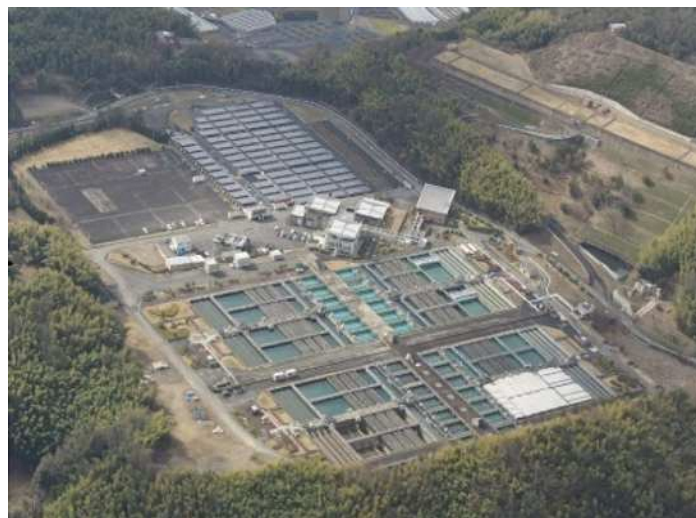
写真 2.3 新山科浄水場 (出典：京都市上下水道局 HP)
