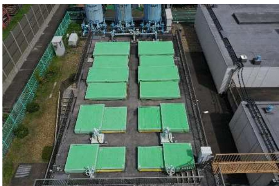
写真 2.5 浄水処理施設全景
