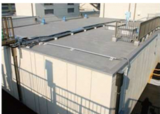
写真 2.7 佐古浄水場配水池
