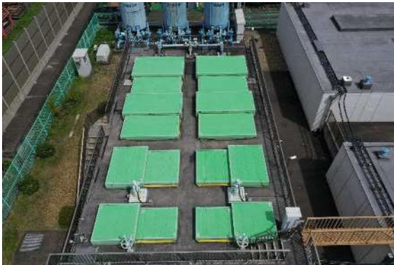
写真 2.5 浄水処理施設全景
