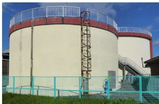
写真 2.8 場外施設配水池
