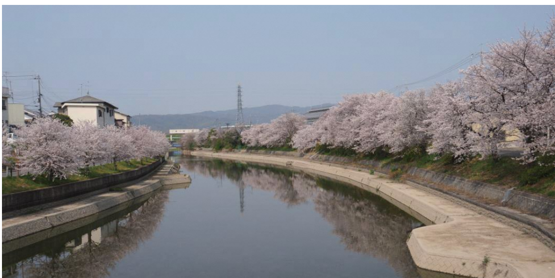
写真 2.2 巨椋池排水幹線
